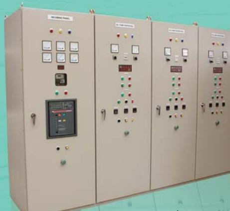
1.4 Pilot Lamp เป็นหลอดไฟฟ้าที่ใช้แสดงสถานะของระบบไฟฟ้า เช่น กรณีไฟฟ้าจากการไฟฟ้าฯ ดับ หลอด Pilot Lamp จะดับลง หรือว่ากรณีที่เซอร์กิตเบรคเกอร์ตัดวงจร (Trip) ก็จะดับลงเช่นเดียวกัน สีของหลอดจะมี 3 สี เท่ากับจำนวนเฟส A, B, C ซึ่งก็จะเหมือนรหัสสีของบัสบาร์
